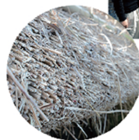
上写真：葺き替え中の屋根を見学する様子。 下写真：吹き替え中の茅のアップ写真。
